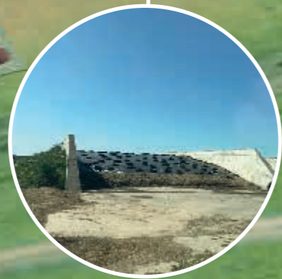
3000 Ton Silo Trench
