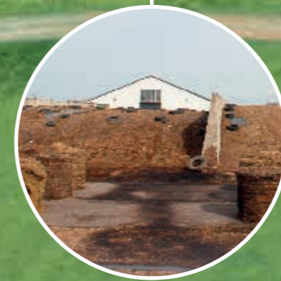
3000 Ton Silo Trench
